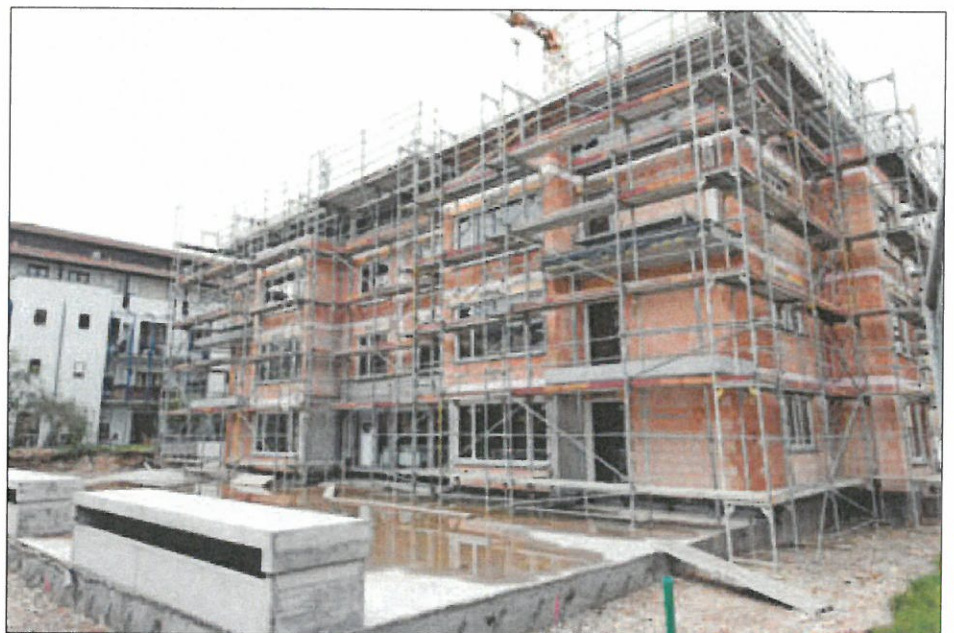
Das Mehrfamilienhaus Meckelhof 13 soll bis Dezember fertig sein. FOTO: ZVG
