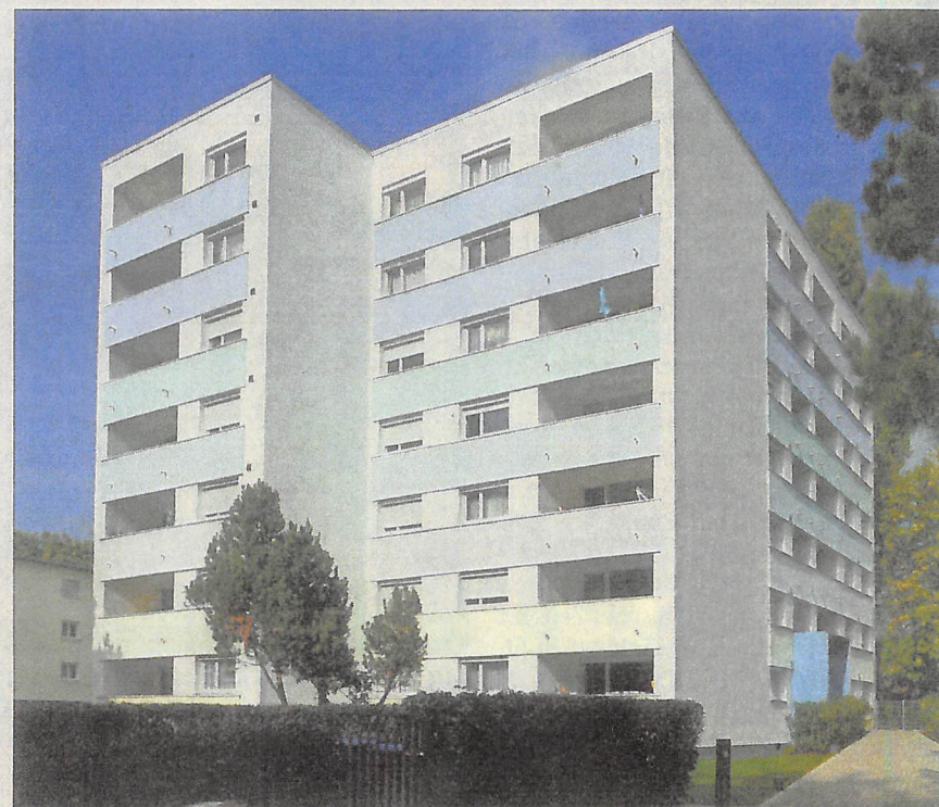
Viele Wohnungen wie hier im Hochhaus im Sterchele in Müllheim wurden saniert.
