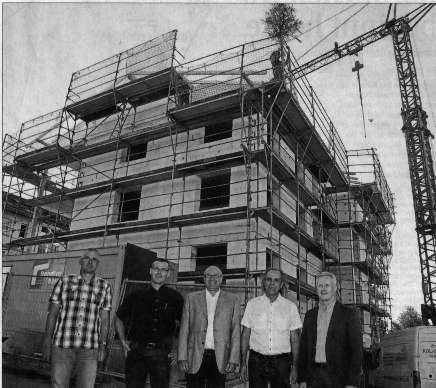
Freuen sich über das gemeinsame Projekt (von links): Steffen Perlitz und Markus Huber (Rendler Bau), Alexander Huber (Baugenossenschaft Familienheim Mittelbaden), Architekt Gerd Schuster und Siegbert Hauser (Baugenossenschaft Familienheim Mittelbaden). Foto: dec
