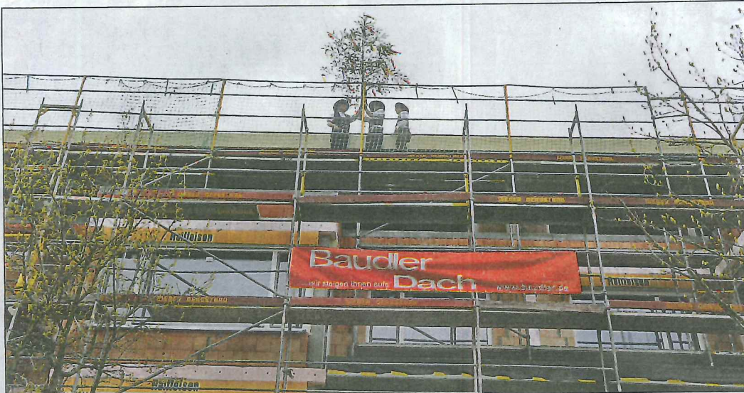
13 Mietwohnungen baut die Familienheim am Meckelhof.
